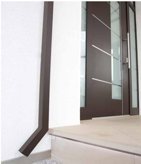
Regenwasser kann durch ein Fallrohr abgeleitet werden.
