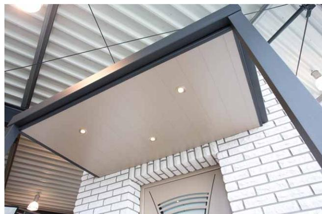
Unteransicht Aluminiumblech genutet mit LED-Strahler
