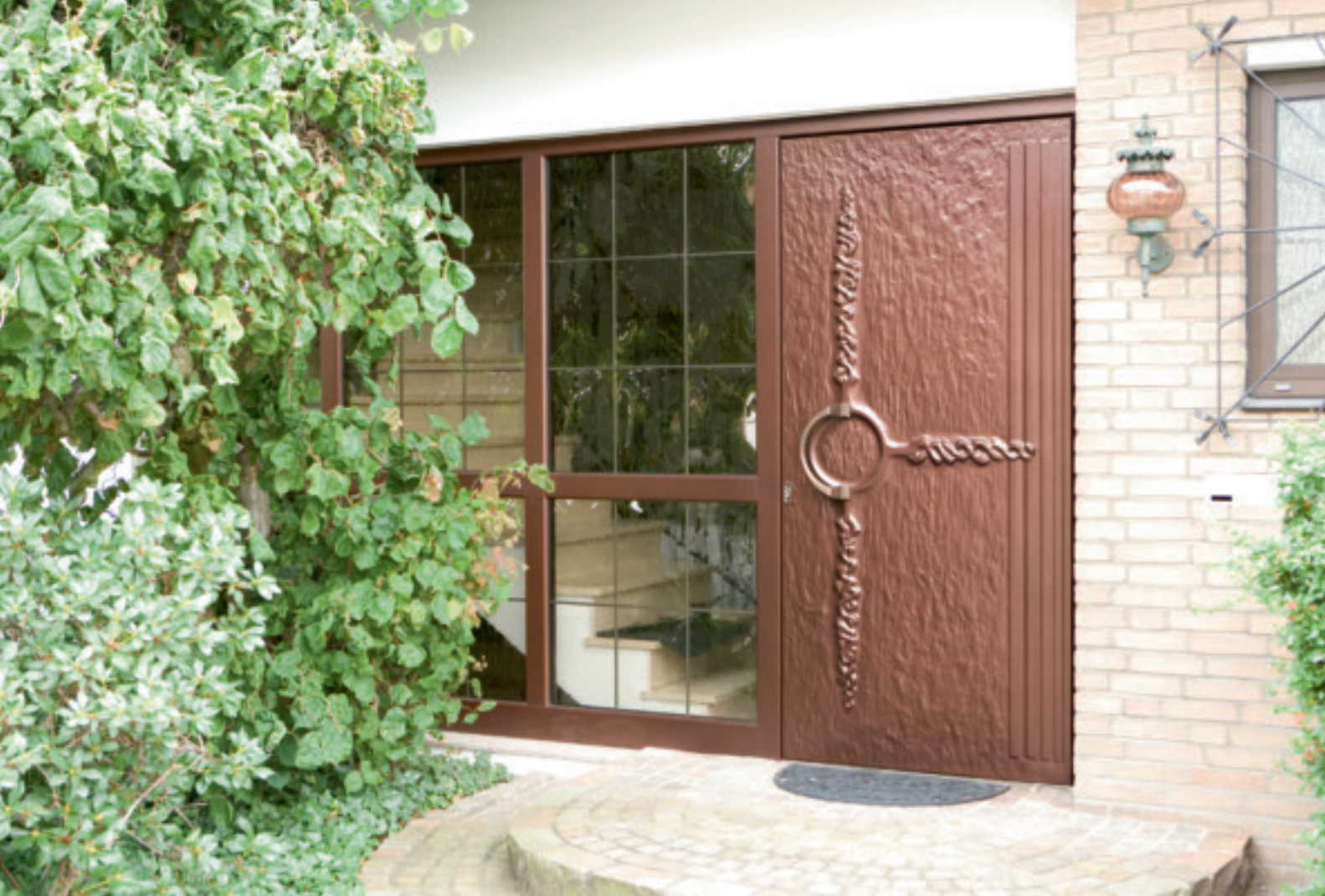
Modell: 32 flügelüberdeckend Farbe: Antiklack kupfer Griff: AG 100 Seitenteil: Butzenverglasung mit Gotthik, Wölbung außen, Bleisprosse innen
