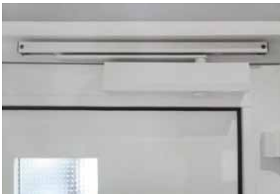
Der Obentürschließer sorgt dafür, dass die Tür automatisch schließt.
